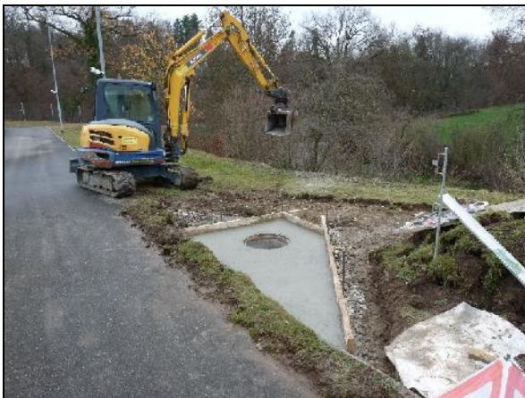
Bau Platzwassereinlaufschacht bei UV7 05. – 07. Dezember 2018
