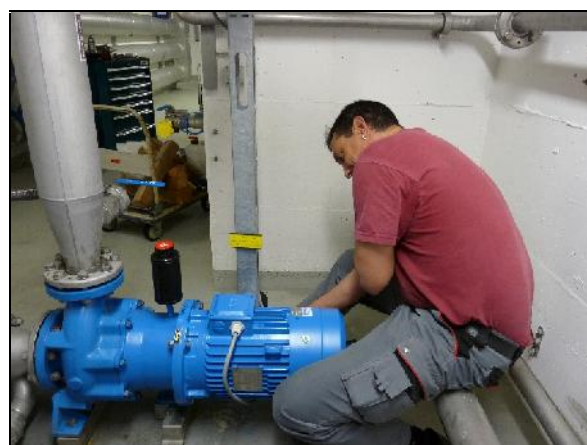
Einbau neue Egger Umwälzpumpe Faulturm 1, 29. Mai 2018
