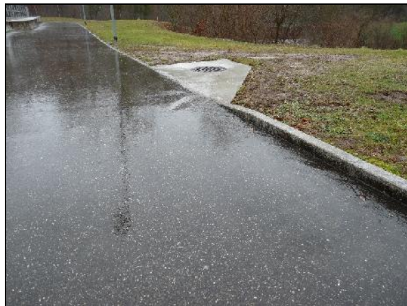
Bau Platzwassereinlaufschacht bei UV7 05. – 07. Dezember 2018
