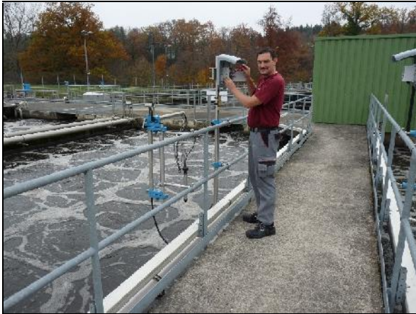
Inbetriebnahme neuer WTW Sauerstoffmessungen in allen 4 Biologiestrassen. 27. – 29. August 2018
