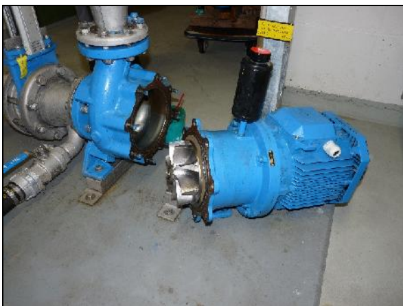
Einbau neue Egger Umwälzpumpe Faulturm 1, 29. Mai 2018
