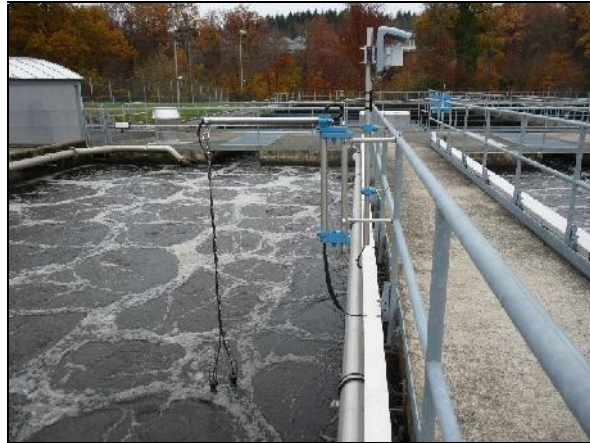
Inbetriebnahme neuer WTW Sauerstoffmessungen in allen 4 Biologiestrassen. 27. – 29. August 2018
