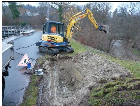
Bau Platzwassereinlaufschacht bei UV7 05. – 07. Dezember 2018
