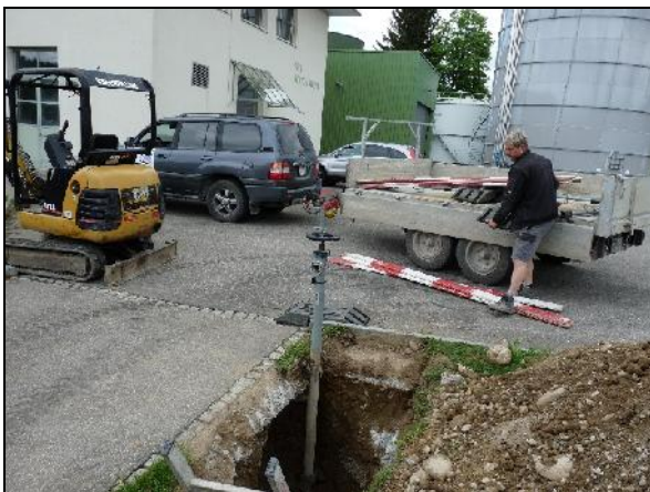
Einbau neuer Hinni Brauchwasserhydrant beim Rechengebäude 02. - 04. Mai 2018
