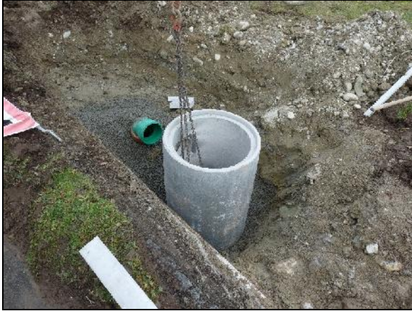
Bau Platzwassereinlaufschacht bei UV7 05. – 07. Dezember 2018
