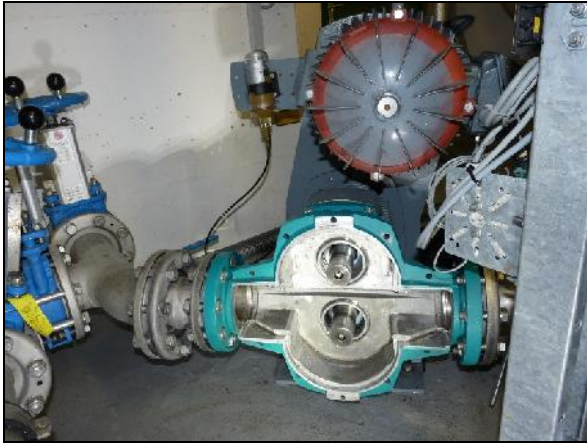
Revision, Tornado Schlamm- Umlagerungspumpe. 07. Mai 2018
