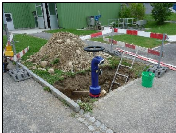
Einbau neuer Hinni Brauchwasserhydrant beim Rechengebäude 02. - 04. Mai 2018
