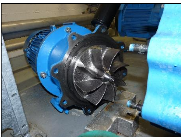
Einbau neue Egger Umwälzpumpe Faulturm 1, 29. Mai 2018
