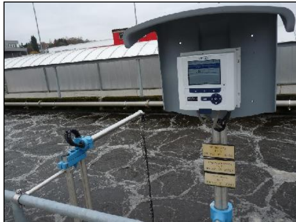
Inbetriebnahme neuer WTW Sauerstoffmessungen in allen 4 Biologiestrassen. 27. – 29. August 2018
