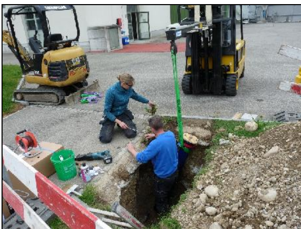
Einbau neuer Hinni Brauchwasserhydrant beim Rechengebäude 02. - 04. Mai 2018
