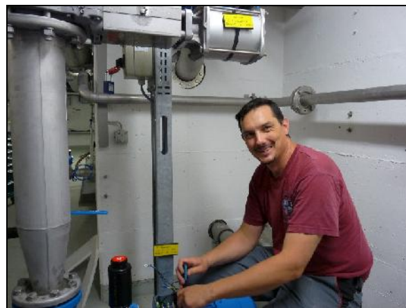
Einbau neue Egger Umwälzpumpe Faulturm 1, 29. Mai 2018
