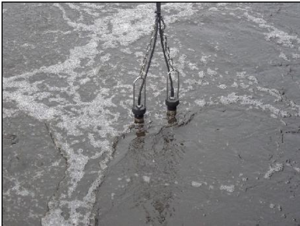
Inbetriebnahme neuer WTW Sauerstoffmessungen in allen 4 Biologiestrassen. 27. – 29. August 2018
