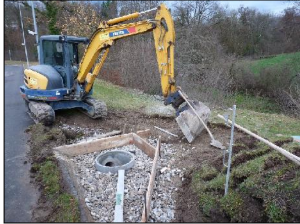
Bau Platzwassereinlaufschacht bei UV7 05. – 07. Dezember 2018
