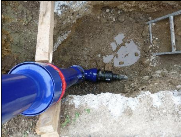
Einbau neuer Hinni Brauchwasserhydrant beim Rechengebäude 02. - 04. Mai 2018
