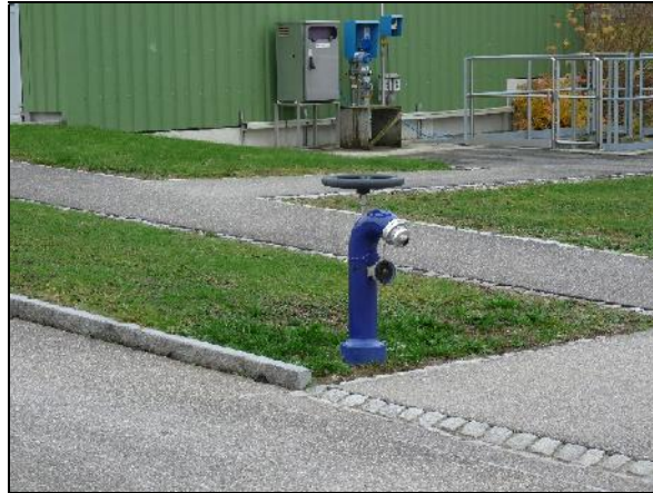
Einbau neuer Hinni Brauchwasserhydrant beim Rechengebäude 02. - 04. Mai 2018
