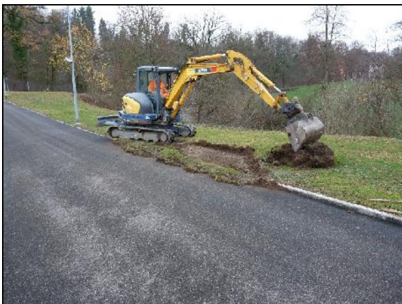
Bau Platzwassereinlaufschacht bei UV7 05. – 07. Dezember 2018
