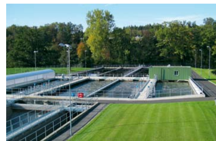
Gesamtansicht Biologie inkl. Schaltwarte
