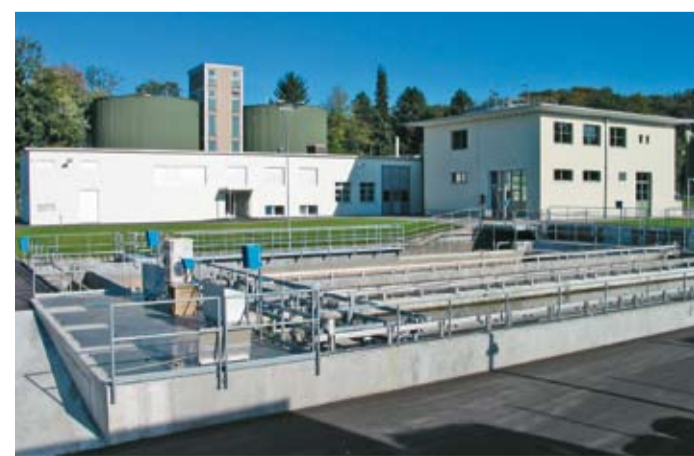
Vorklärbecken (vorne), Betriebsgebäude, Faultürme, Maschinenhaus (hinten v. l. n. r.)
