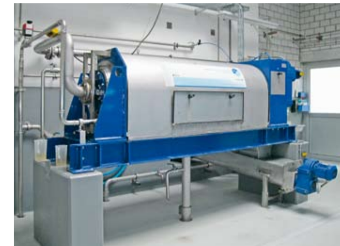
Schlammwässerungsanlage (Schneckenpresse)
