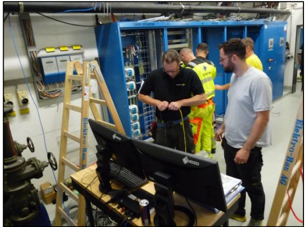
Umbauarbeiten Schaltschränke UV5 Heizungsanlage Oktober 2025
