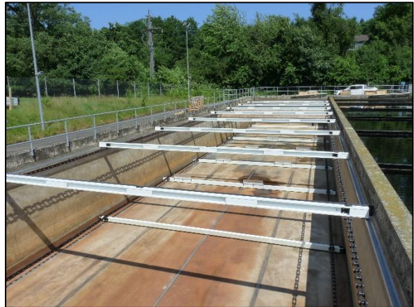
Montage neuer DEWA Kettenräumer in NKB1, durch Frei AG Servicemonteure Mai 2025
