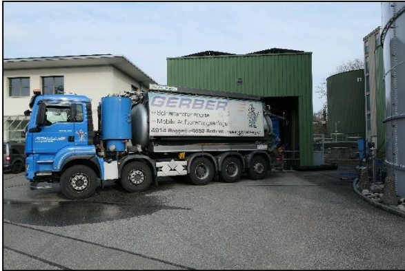
Faul & Trübwasserstapel, extreme Schlammrückstände durch Gerber AG absaugen und 42m 3 Ablagerungen in der ERZO in Oftringen entsorgen 26. März 2025
