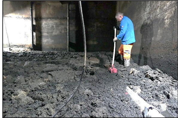
Faul & Trübwasserstapel, extreme Schlammrückstände durch Gerber AG absaugen und 42m 3 Ablagerungen in der ERZO in Oftringen entsorgen 26. März 2025
