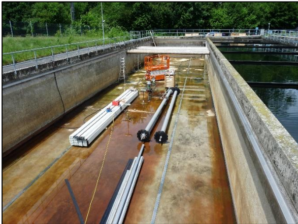
Montage neuer DEWA Kettenräumer in NKB1, durch Frei AG Servicemonteure Mai 2025
